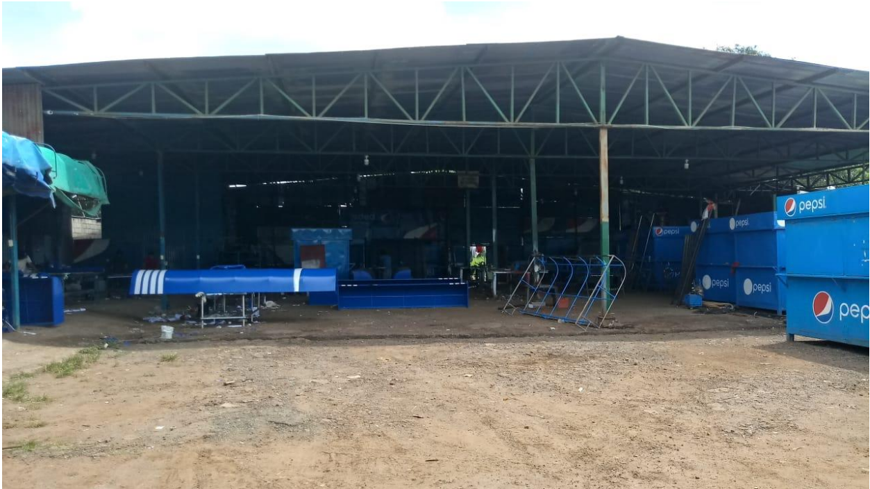
Departamento de obra. Marzo 2018
