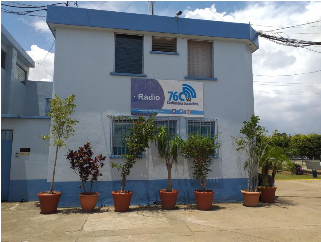
Entrada principal de Radio 760AM donde se puede observar la antena en la parte superior.
