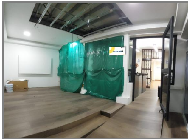
Figura 15. Montaje señalética Recepción
