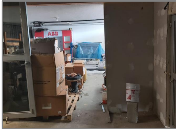
Oficinas en remodelación Fuente: elaboración propia
