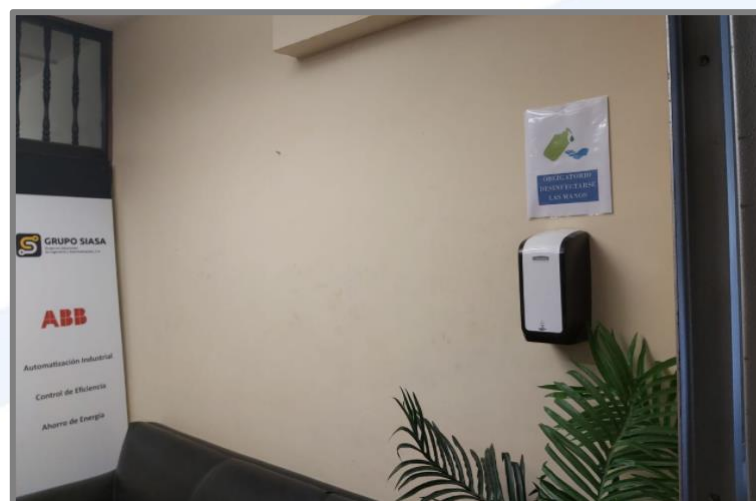
Dispensador de gel está mal ubicado
