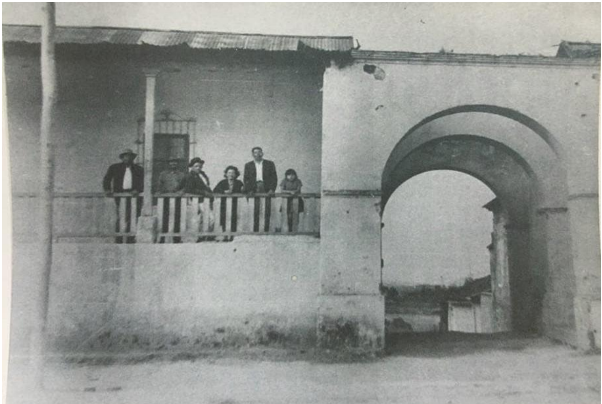
Figura 2 Edificio anexo de la Municipalidad de Mixco
