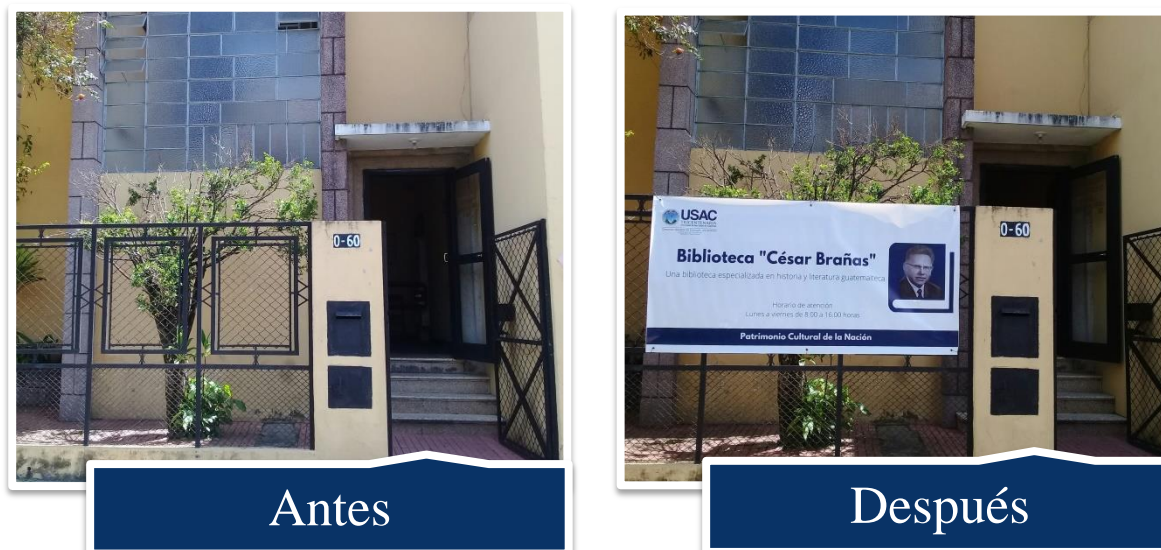
Vista de la fachada con lona vinílica Fuente: Elaboración propia.
