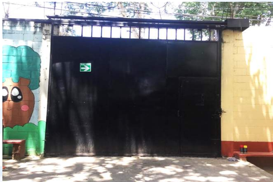
Figura 56 Señal salida de emergencia (Portón)
