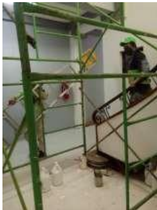
Verificar uso de equipo de trabajo en cuadrilla de pintura que está trabajando en el edificio de desarrollo social.
