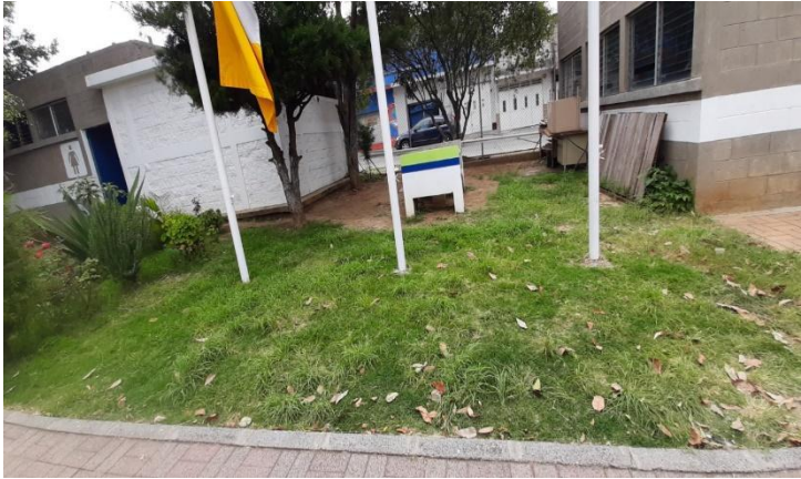
Figura 36. Imágenes del proceso de instalación del rótulo en las instalaciones del CEM
