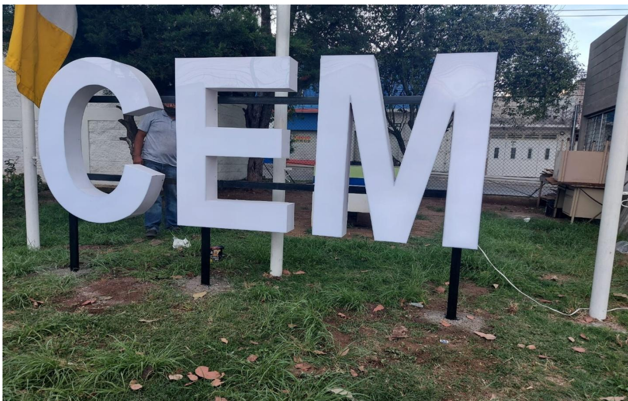
Figura 22. Instalación de rótulo en Centro Educativo CEM
