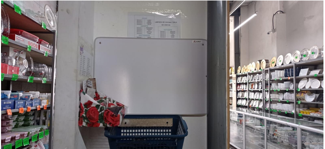
Figura 22 Colocación de Tablero
