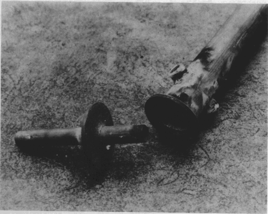
Fotografía 6. Detalle de las bridas que están colocadas en los extremos de los tubos externos.
