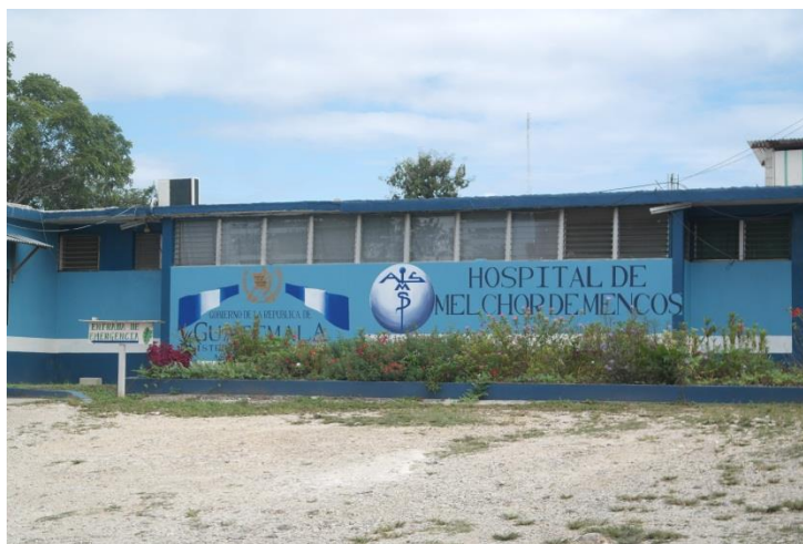
Ilustración 2: Fachada frontal del Hospital Nacional de Melchor de Mencos, Petén.
