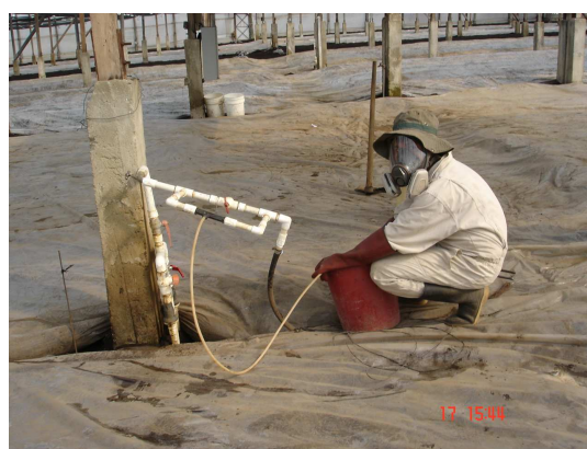
Figura 16. Proceso de inyección de Telone
