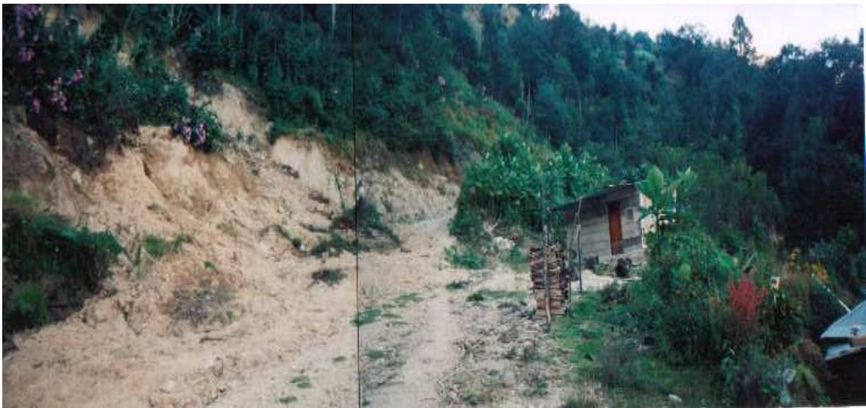
**Figura 13: Deslizamiento ocurrido cerca de una vivienda provisional, la vivienda situada a la derecha de la fotografía presenta una serie de agrietamientos.**
