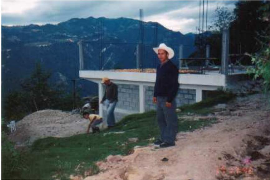
**Figura 14: Vivienda formal en una plataforma de corte**
