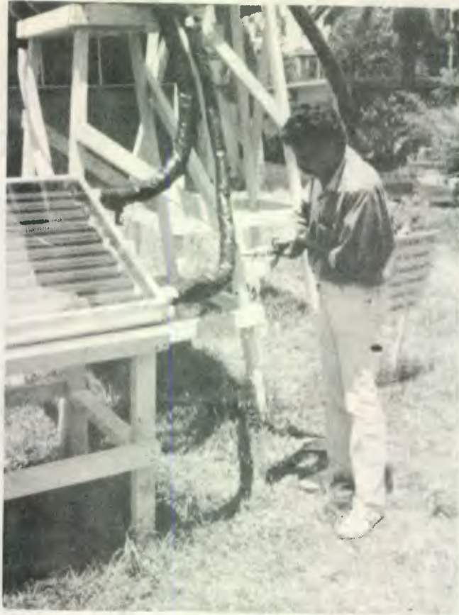
FIGURA 24 Extracciones periódicas de agua caliente para verificar el rendimiento del sistema experimental en la época de Invierno bajo condiciones fuertes.
