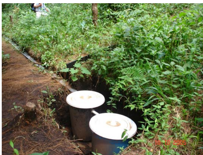
Figura 55. Sistema colector de escorrentía
