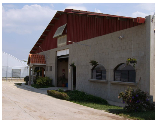
Figura 1.5. Fachada de oficinas
