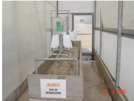
Figura 1.11. Entrada y batería de lavamanos
