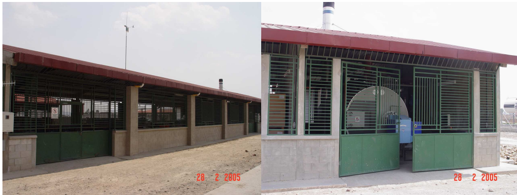
Figura 1.6. Bodega de cuarto de fertilización y caldera
