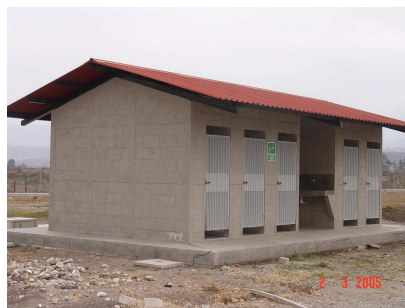
Figura 1.8. Batería de baños
