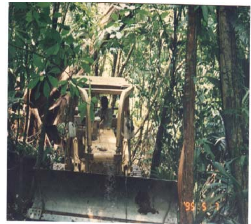
Figura 2: Apertura de camino con tractor D5B
