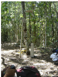
Figura 13. Siembré de mojón y geoposicionamiento de esquinero
