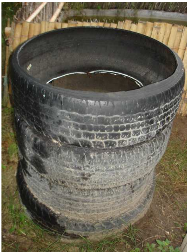
Figura 2.41A El pozo de llantas terminado para captar el agua de la lluvia.
