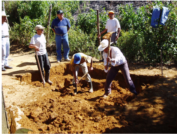
Figura 2.31A Trazo, medición, excavación y extracción de la tierra del agujero base del pozo artesanal.
