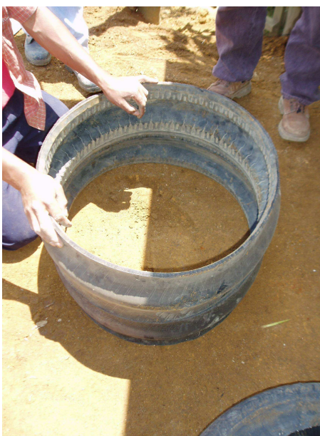
Figura 2.37A Se colocan las llantas apiladas o de forma vertical una sobre de otra para coserlas posteriormente.
