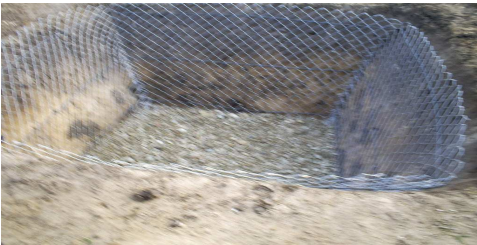
ESTRUCTURA Fe. 3/8" Y MALLA GALVANIZADA
