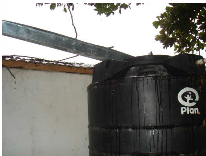
Figura 2.47A Colocación del canal cuadrado en la entrada del tanque de plástico vertical para la captación del agua de la lluvia a través del techo.
