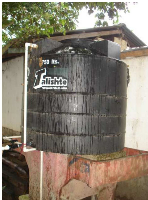
Figura 2.46A Se colocó sobre un lugar seguro y estable, de fácil conexión a la tubería principal y debajo del techo de la casa.
