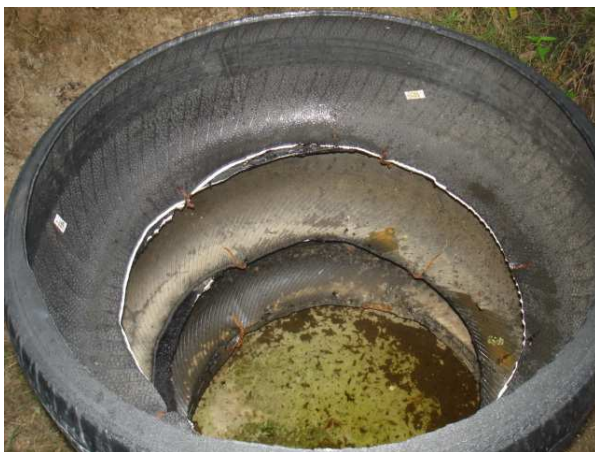
Figura 2.40A Finalmente se le echan dos capas de pegamento por la parte de afuera de las llantas, entre las uniones, para que termine de sellar y evite que existan fugas.
