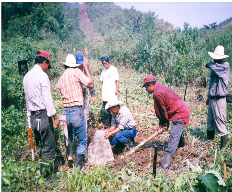
Figura 36A. Colocación de Mojones en los diferentes vértices de la lotificación.
