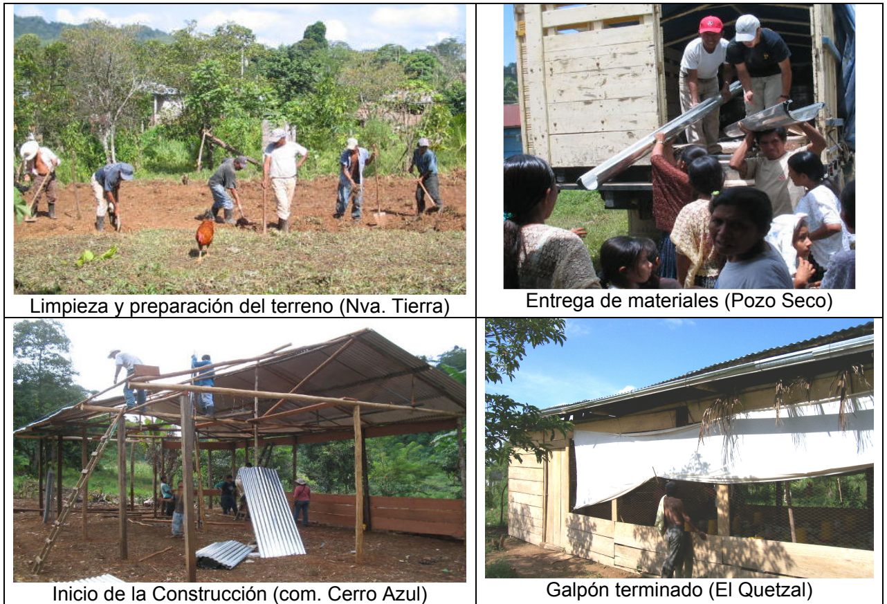
Figura 3.18. Distribución de materiales y construcción de galpones
