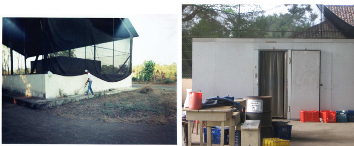
Figura 62 Pintado y Limpieza del cuarto frío
