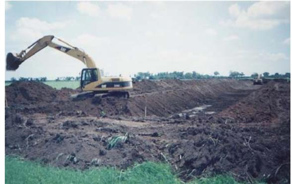
Figura 12: Continuación de la Excavación de una poza
