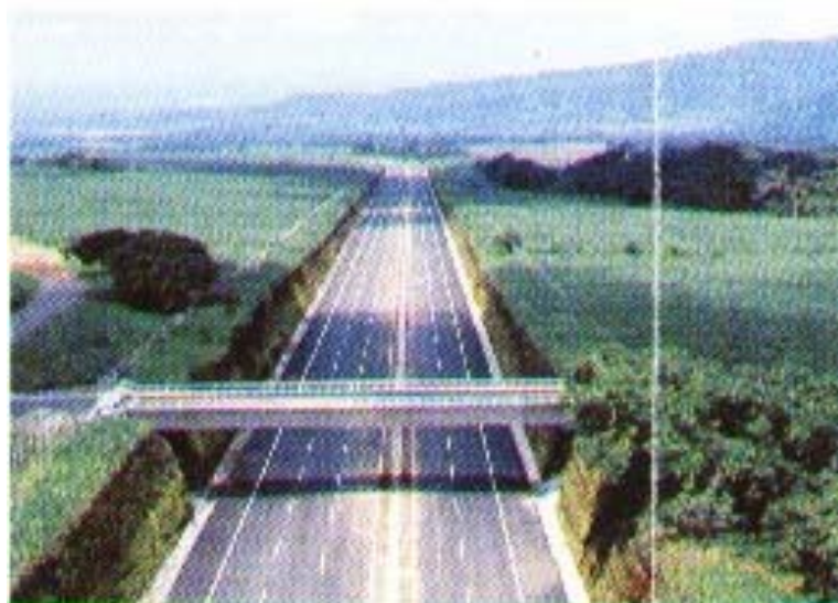
Foto 18 Vista de paso de servicio.
