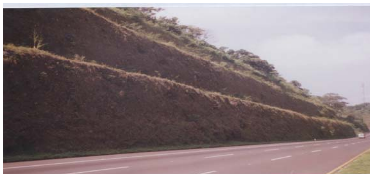
Foto 9 Talud mostrando terrazas de banco.
