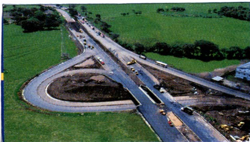
Foto 6 Inicio de la Autopista Palín-Escuintla CA-9 Sur a la altura del kilómetro 38.02
