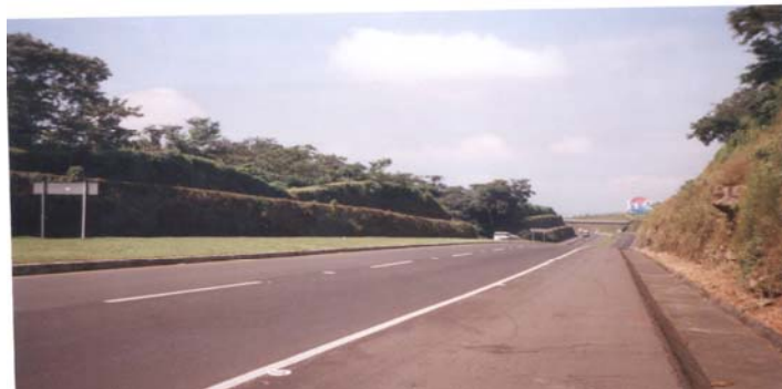
Foto 19 Taludes y derecho de vía sin reforestar.
