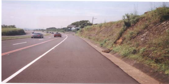
Foto 15 Talud cubiertos con vegetación natural.
