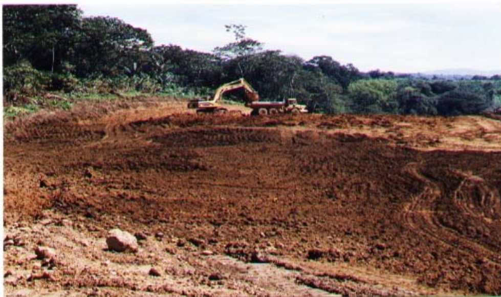
Foto 5 Remoción de suelo en la Construcción de la Autopista Palín – Escuintla
