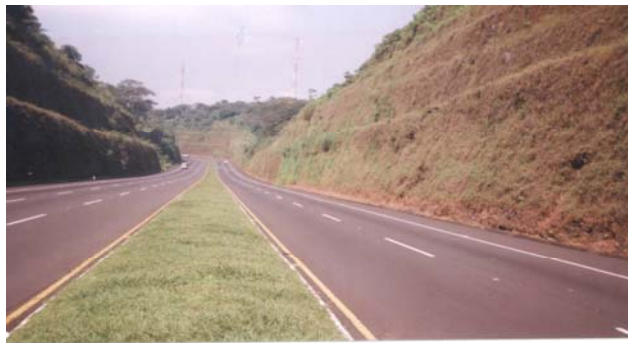
Foto 8 Talud con terrazas de banco sin reforestar.
