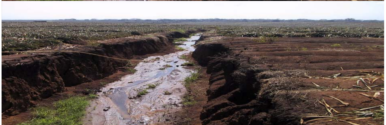
Figura 5A: Drenaje primario en finca La Plata, Coatepeque, Quetzaltenango.
