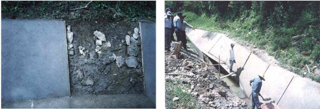
Fotografía No 3 y 4: Renovación de las lozas de concreto del canal principal.
