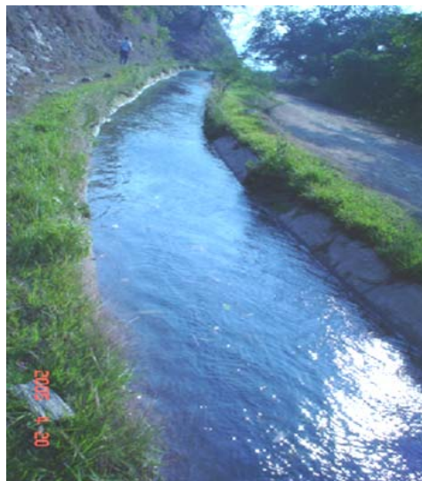
Fotografía No. 9: Uno de los tramos del canal central del sistema transportando su máximo caudal con dimensiones de 1.5 mts de profundidad y 2 mts de ancho.
