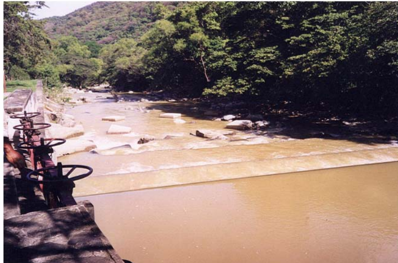
Fotografía No 5: Aspecto del agua justo antes de entrar al canal principal del sistema de riego de San Jerónimo, se encuentra con sedimentos debido a las lluvias y al mantenimiento de la hidroeléctrica a unos 10 Km. en la parte superior de la cuenca.
