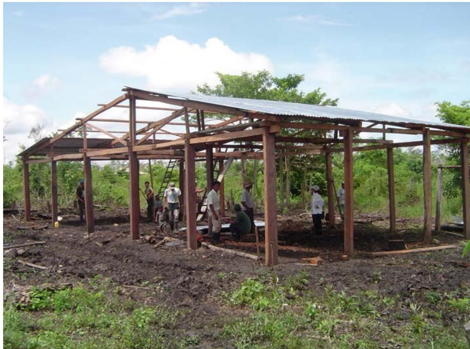
Figura 5. Construcción de la galera para el trapiche y el horno para coser el jugo de caña.
