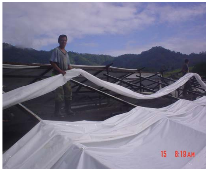
Figura 15A. Mantenimiento del invernadero, cambio de plástico y renovación de madera en mal estado, finca Bella Vista, 2004.
