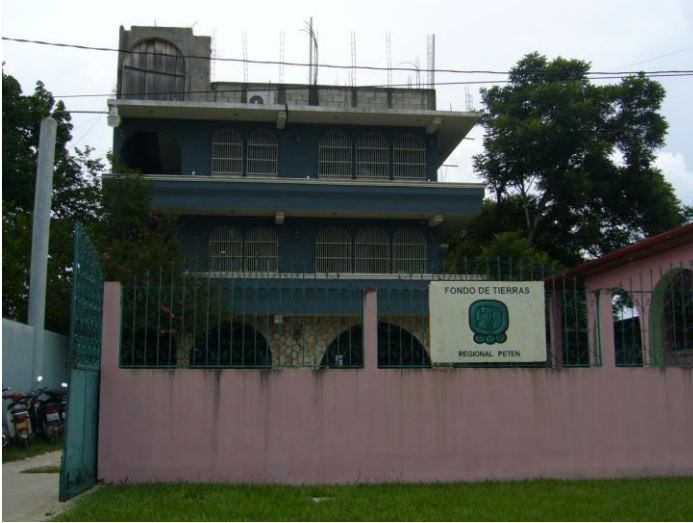
Instalaciones del Fondo de Tierras, Subgerencia de Petén, Santa Elena.
