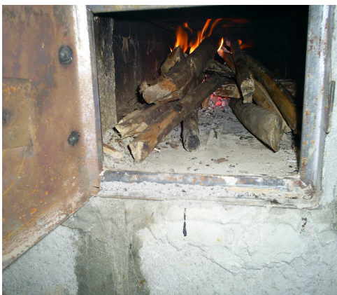
Fig. 13 Compuerta de las estufas del proyecto
