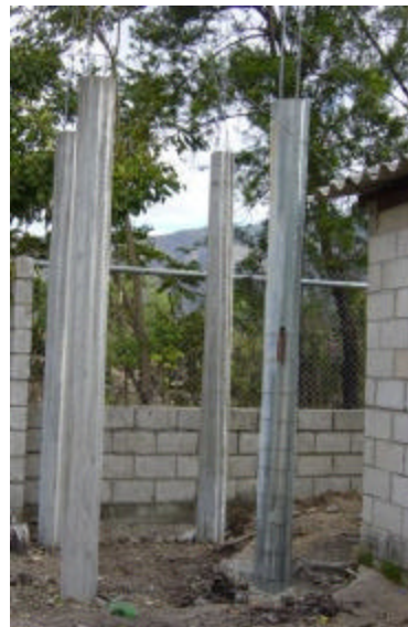
Figura 3.28. Construcción de la torre.agua
