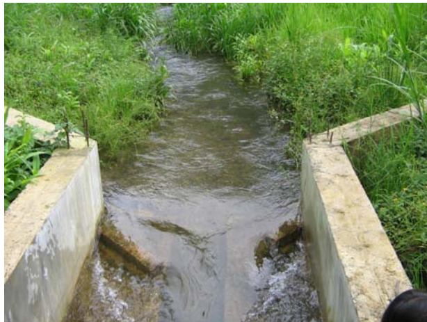
Figura 4. Canal de aforo del caudal del Río Frío
