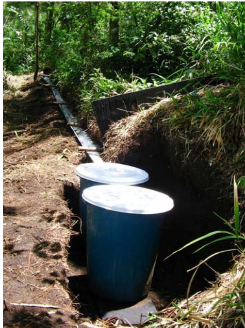
Figura 15. Sistema colector de agua y sedimento
