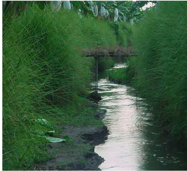
Figura 44 Cobertura vegetal usando *Vetiveria zizanioides* (vetiver) para taludes de canales de agua.
