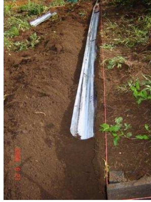
Figura 2.4. Canal colector de hojalata.
