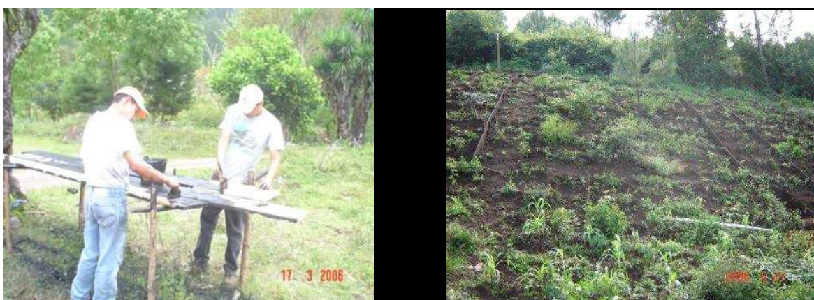
Figura 2.2. Tablas tratadas con aceite quemado y diesel. Figura 2.3. instalación de tablas en el suelo.
