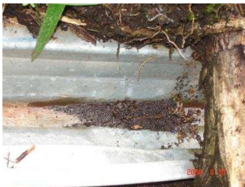
Figura 2.10. Limpia de canales.
