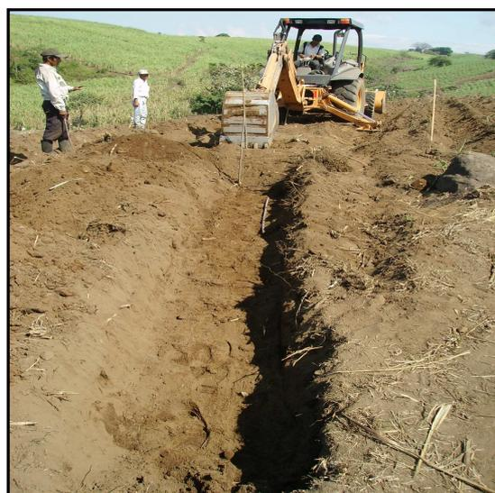
**Fotografías que muestran la ubicación, diseño de zanjas de infiltración.**
