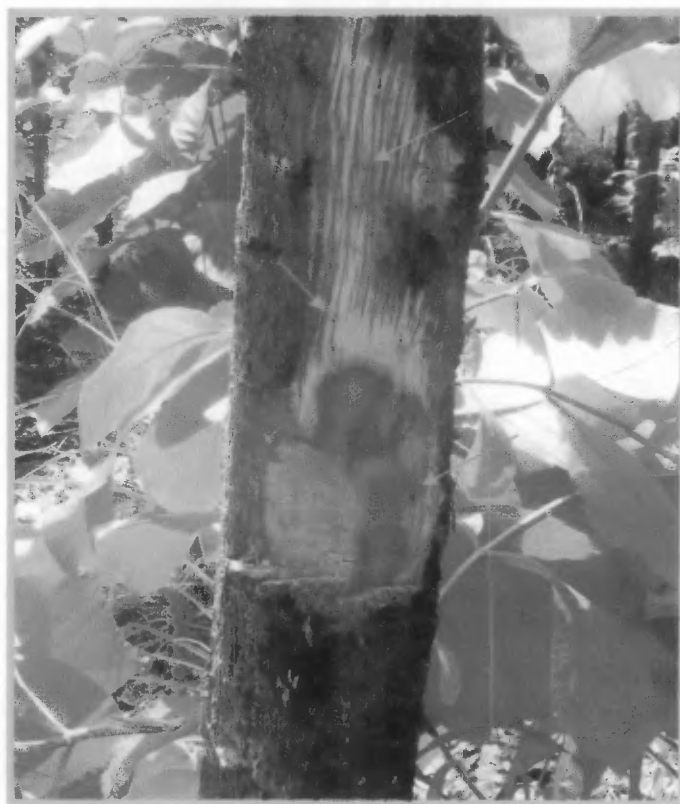
Figura 40 Orificios realizados por Xyleborus sp. en el fuste de un árbol de teca
