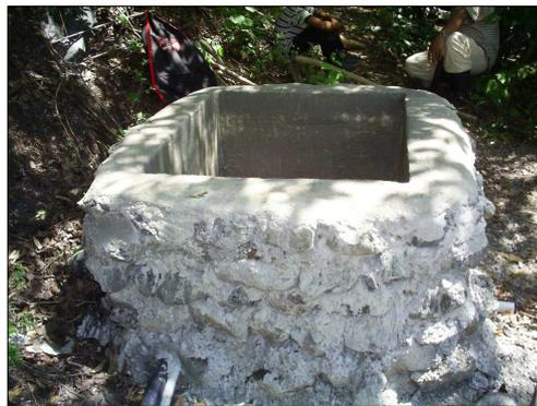
Figura 23A. Caja de captación, para el proyecto “Establecimiento de un huerto comunal con sistema de riego por goteo” en aldea Patache, 2005.
