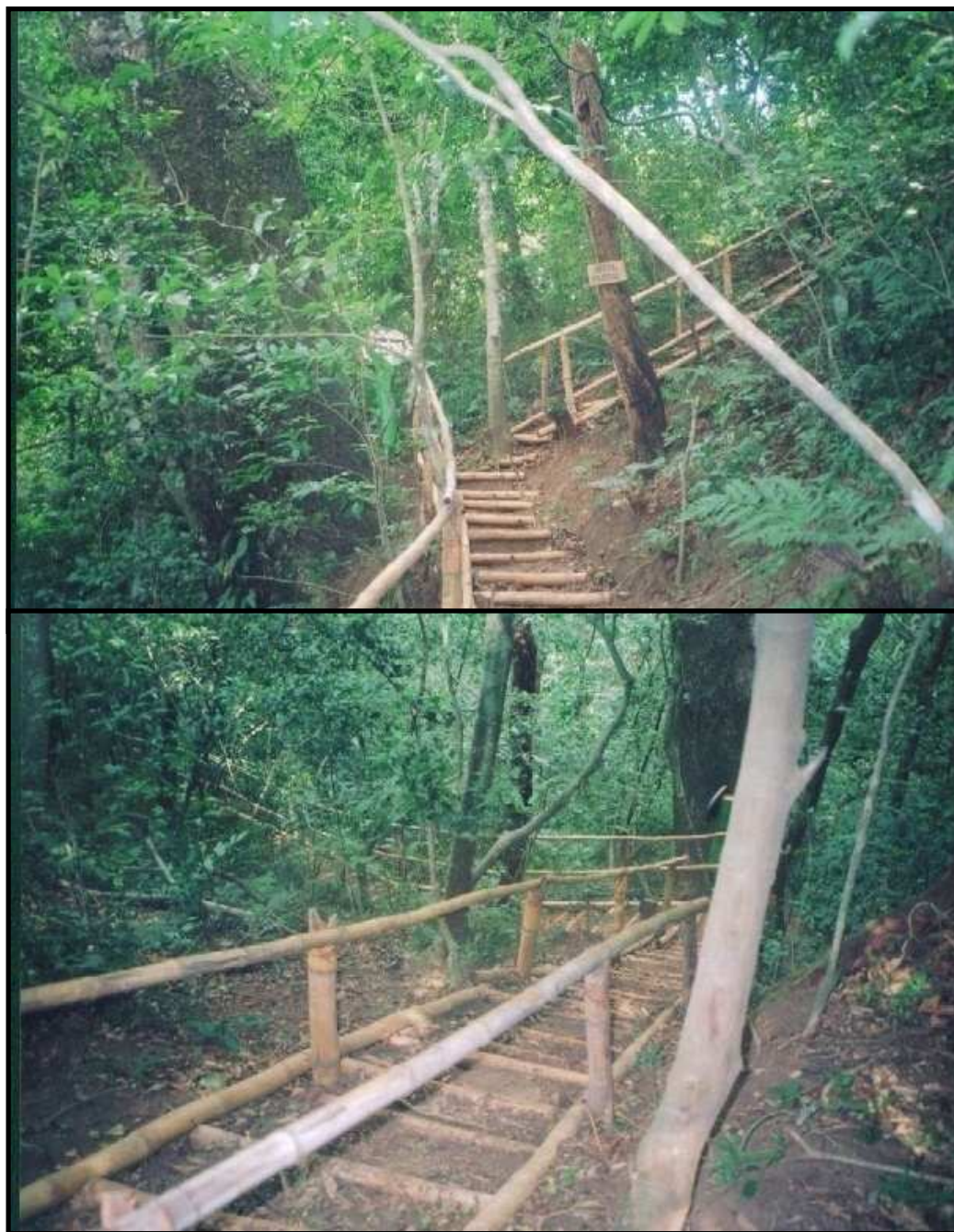
Figura 18. Escalinatas reparadas y con el paso expedito.
