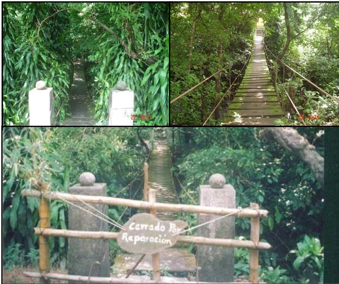
Figura 14. Señalización de puente en reparación de ingreso principal al sendero ecológico la Danta.
