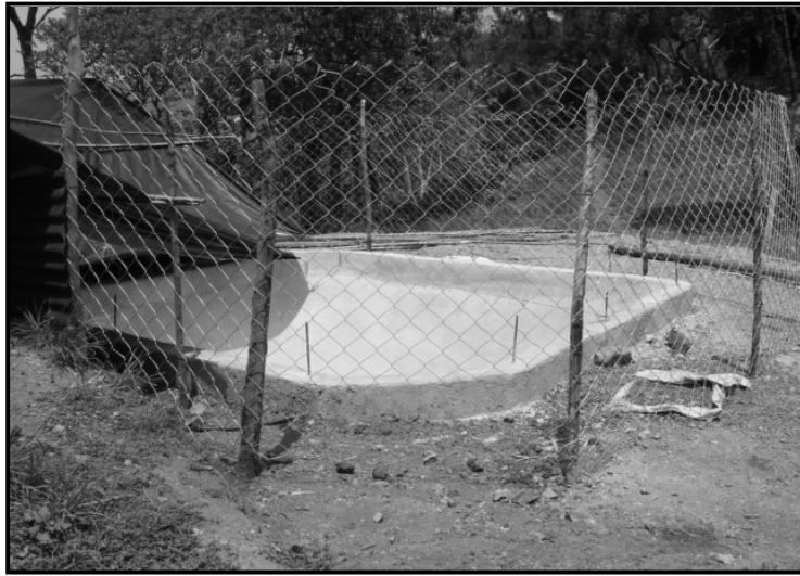
Figura 3.31 Tanque de captación de agua de lluvia en la comunidad de Suquinay, Purulhá, B.V.
