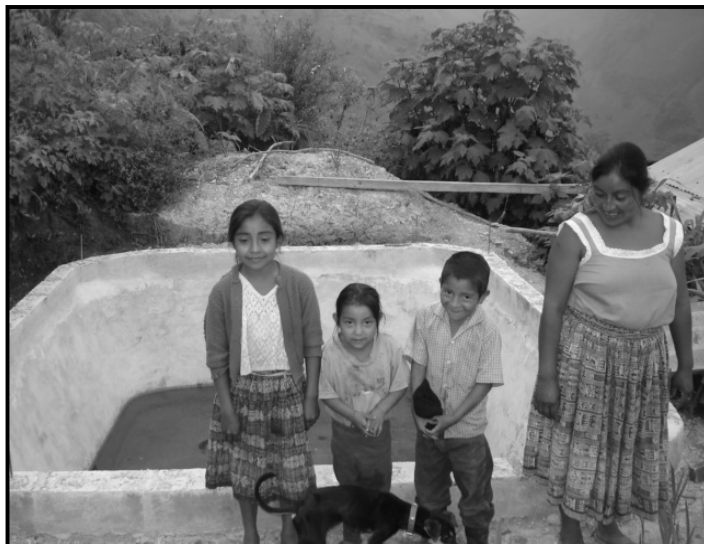
Figura 3.30 Tanque de captación de agua de lluvia en la comunidad de Panimaquito, Purulhá, B.V.
