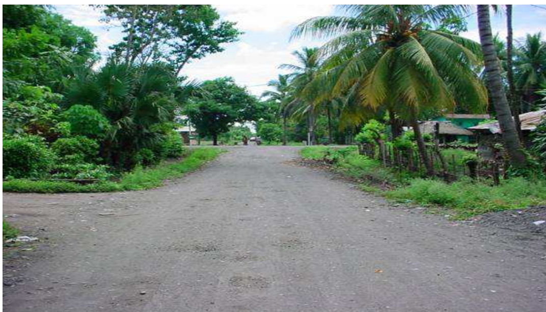
Figura 6. Calles de terracería de la aldea Centro 2.
