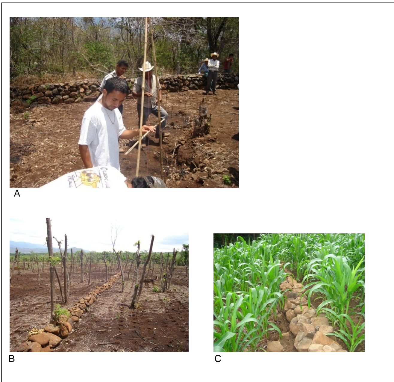
Figura 3.3 A: Capacitación de manejo del nivel tipo A en caserío Tierra Colorada Aldea Estancia de San Martín J. B-C: Estructura de conservación de suelos en San Antonio Chuatalum
