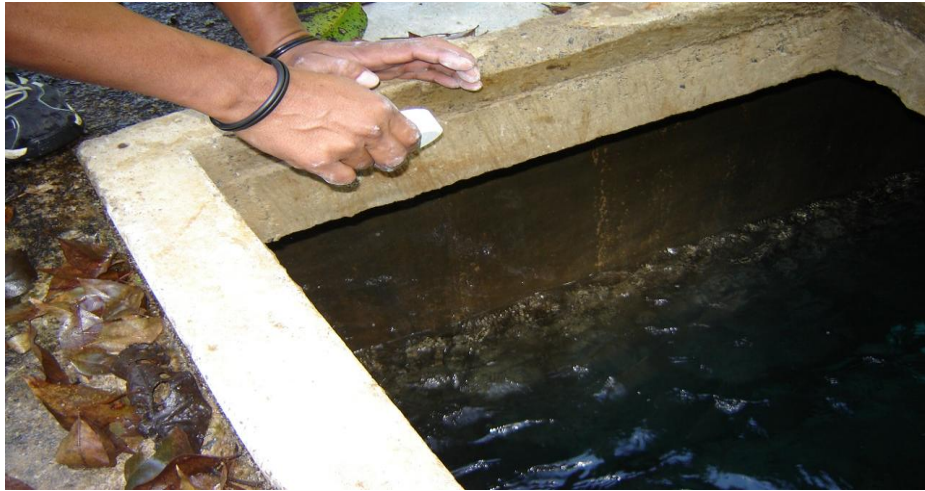
Figura 7 Aplicación de pastillas de cloro
