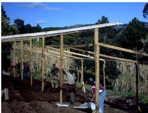
Figura 3-19 Colocación del plástico especial sobre la estructura de madera
