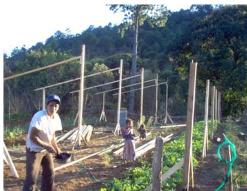
Figura 3-17. Construcción de la estructura de madera del invernadero en San Miguel
