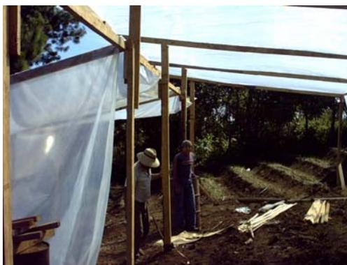
Figura 3-18 Colocación del plástico especial sobre la estructura de madera
