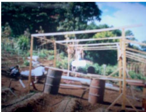
Figura 3-16. Construcción de la estructura de madera del invernadero
