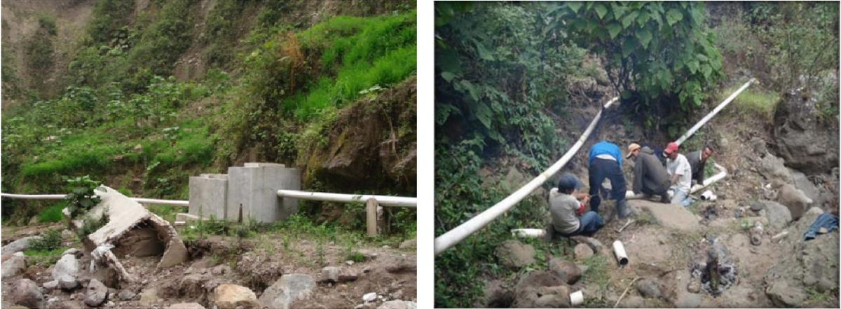
**Figura 20. Daño a la tubería principal de conducción del sistema de riego gravedad-aspersión.**
