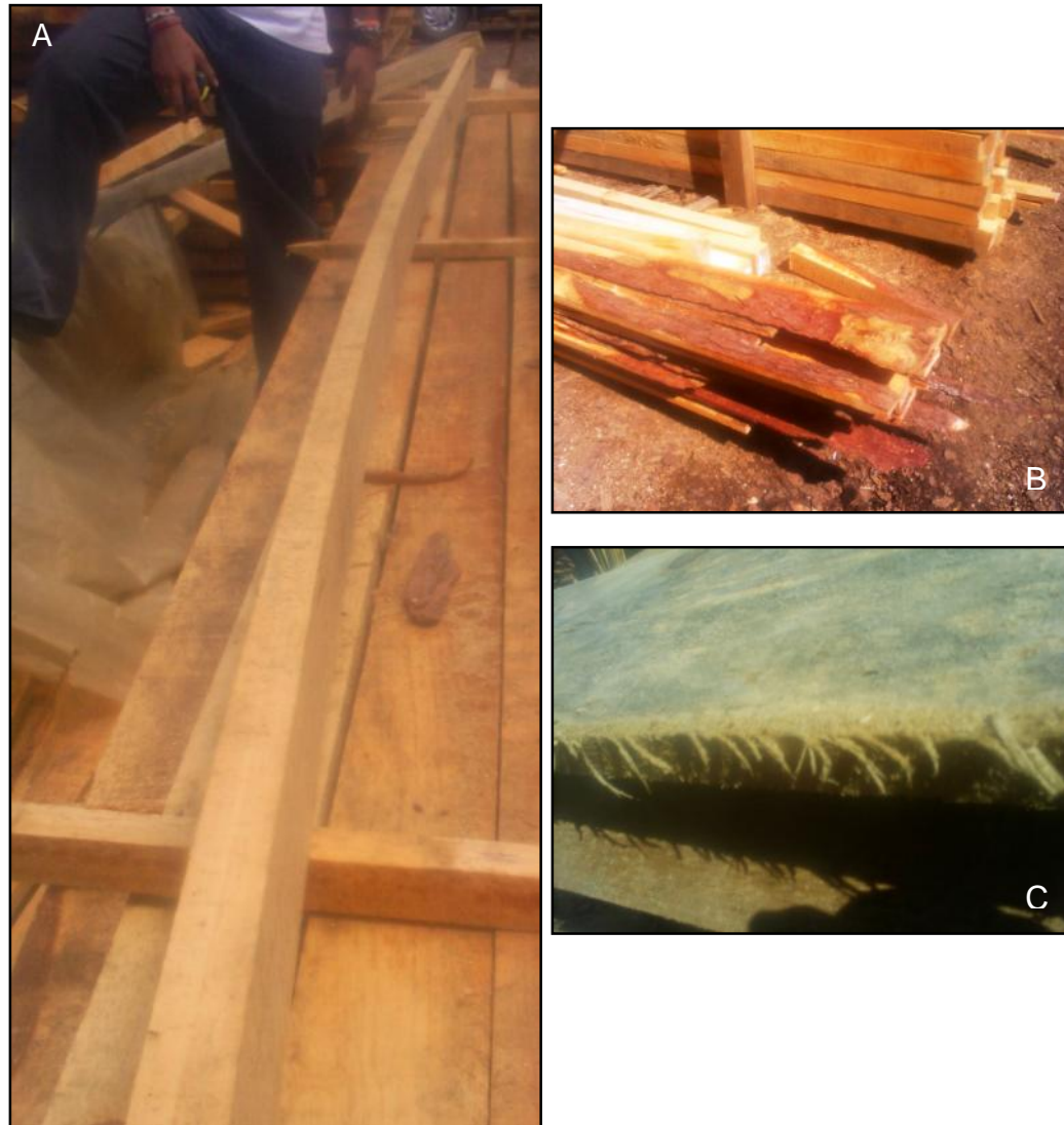
Figura 31. Entre las imperfecciones de manufactura están: (A). Productos curvados. (B). Entrecasco. (C). Arañazos de máquina.
