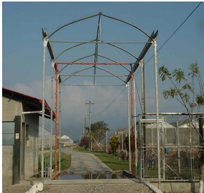
Figura 49. Arco de desinfección para vehículos que ingresan a la empresa
