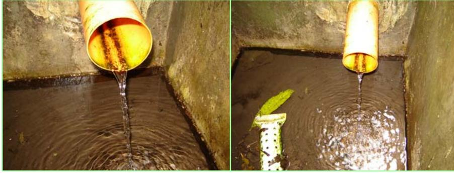
Figura 54. Cajas de captación del agua del manantial 1, PRM Cantel
