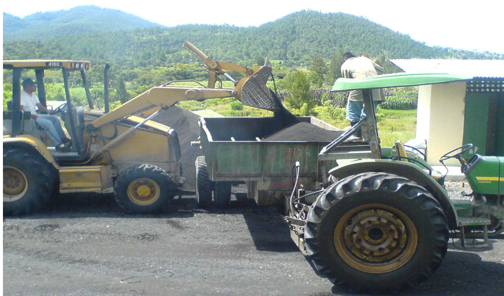
Figura 6. Llenado de carretón con cargador frontal.
