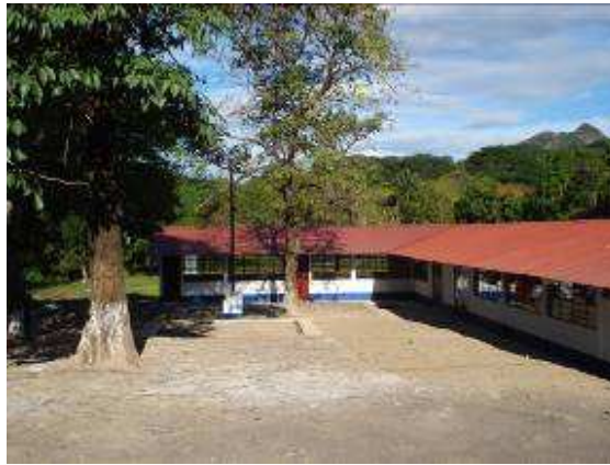
Figura 17. Edificio de usos múltiples (textilera, computación y carpintería)
