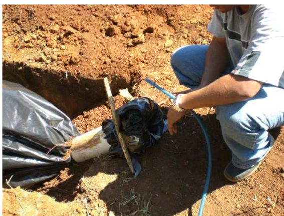
Figura 30. Introducción de agua dentro del biodigestor
