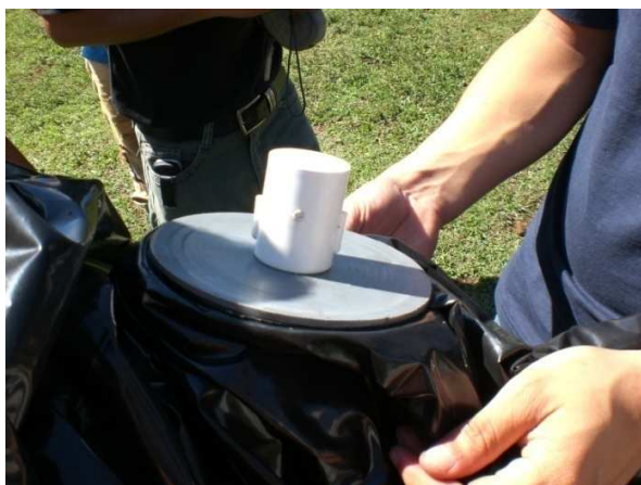
Figura 25. Válvula de salida del biodigestor
