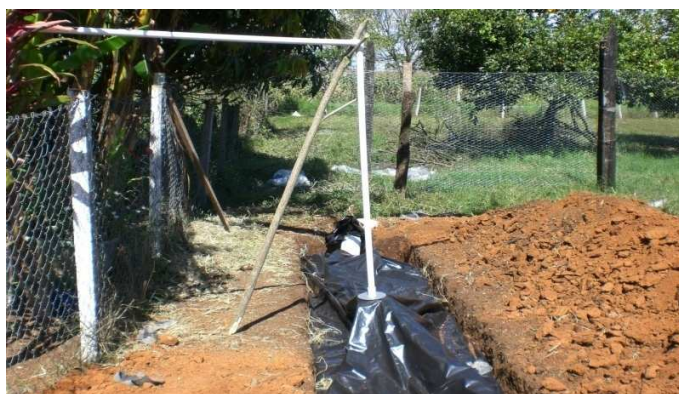
Figura 34. Biodigestor instalado finca La Ceiba, Santa Rosita, Dolores, Peten.
