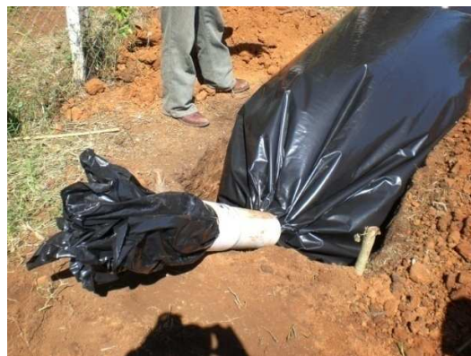
Figura 28. Colocación de tubos de PVC que sirven de entrada y salida de sólidos del biodigestor.
