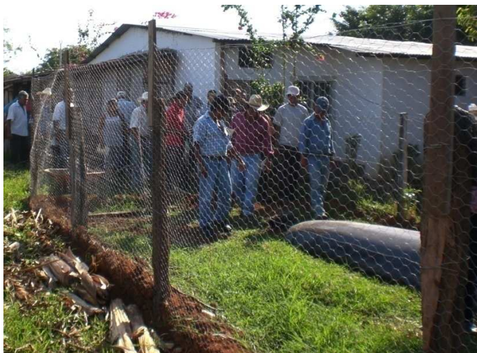
Figura 33. Malla circulando el biodigestor para protección
