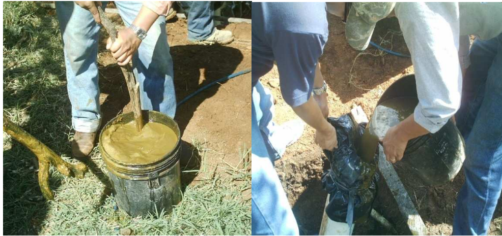
Figura 31. Preparación e introducción de la mezcla dentro del biodigestor
