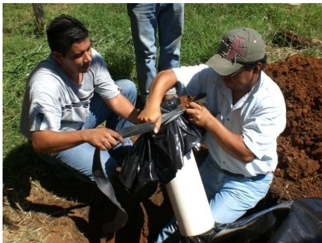
Figura 29. Colocación de tiras de hule que sirven para sujetar el nylon a la entrada y salida del biodigestor.
