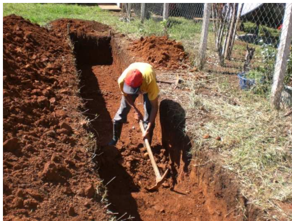
Figura 21. Preparación de la fosa para ubicación del biodigestor
