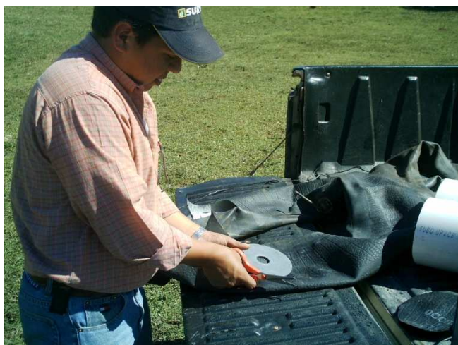
Figura 23. Preparación de válvula de salida del biodigestor.
