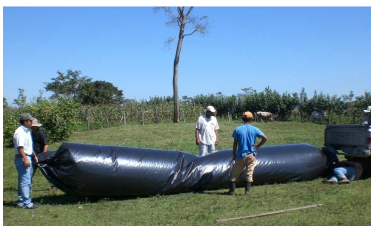
Figura 26. Inflado de la bolsa con el adaptador
