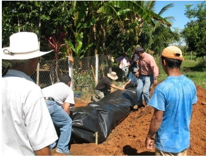
Figura 27. Traslado de la bolsa hacia la fosa
